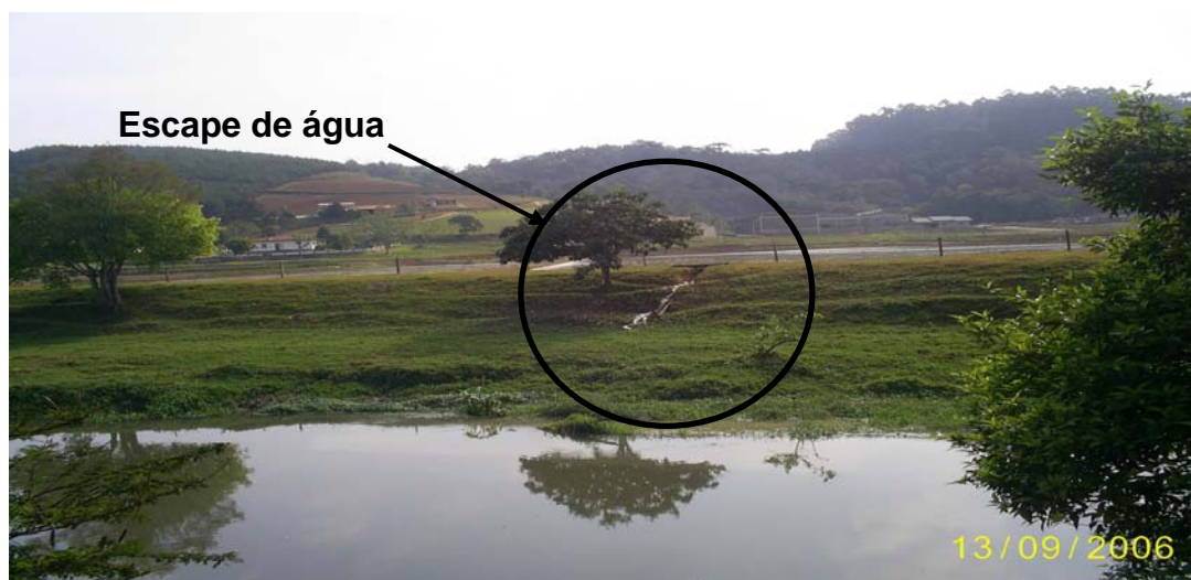
Figura 4. Manejo inadequado das águas após aplicação de defensivos.
