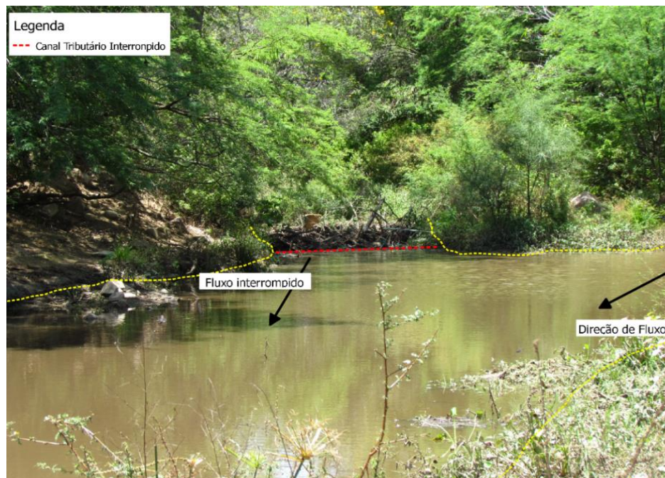
Figura 9. Tributário interrompido com cerca de arame farpado e acúmulo de entulho e lixo oriundos dos fluxos torrenciais a jusante, interrompendo o fluxo de água e sedimento até no nível que a barreira é extrapolada.
