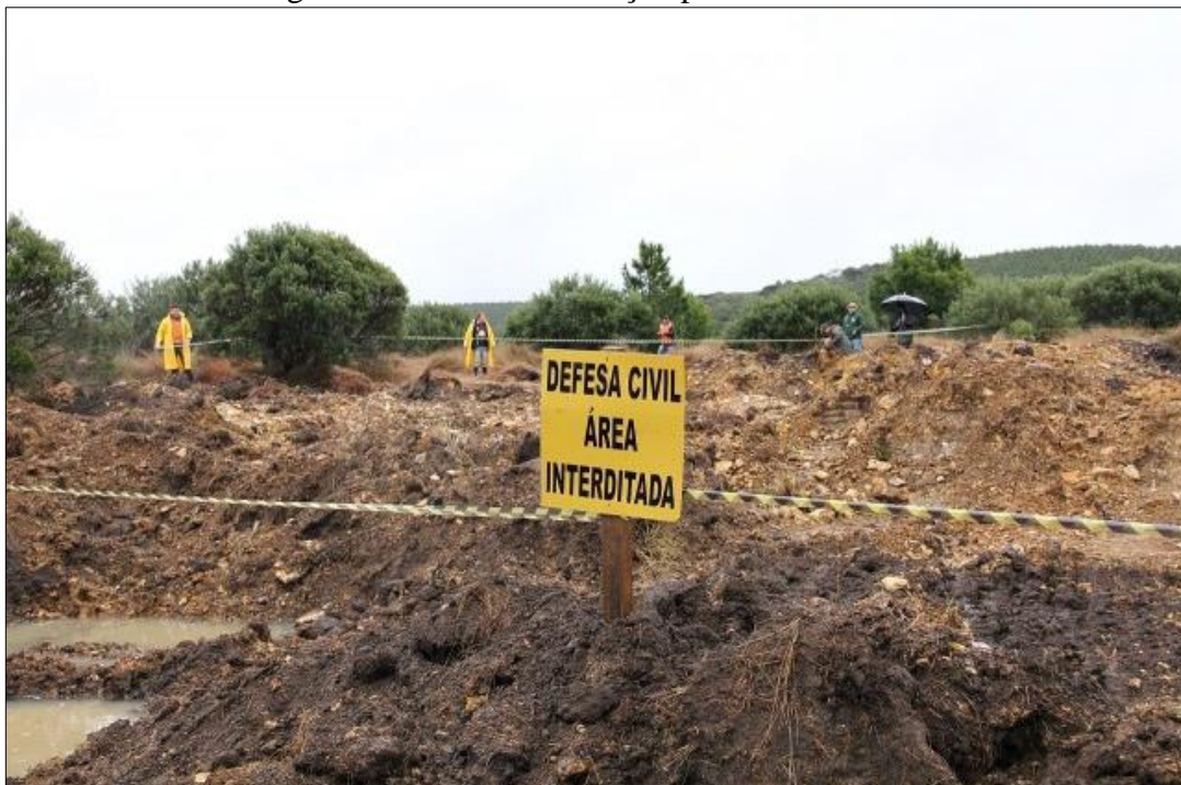
Figura 6 - Placa de interdição pela Defesa Civil.
