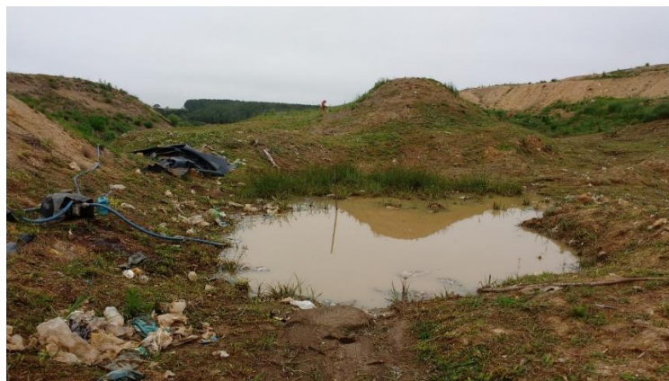
Figura 9 - Vazamento e acúmulo de lixiviado em solo não impermeabilizado.
