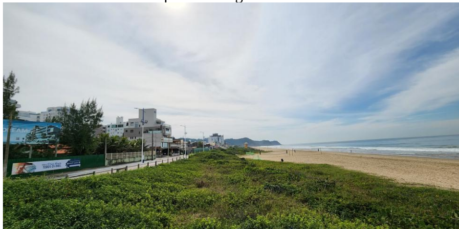
Figura 11: Conjunto de edificações sem presença de sombreamento às 12:50h no mesmo ponto da Figura 9.
